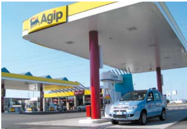
Particolare della stazione multi-energy dell'ENI
